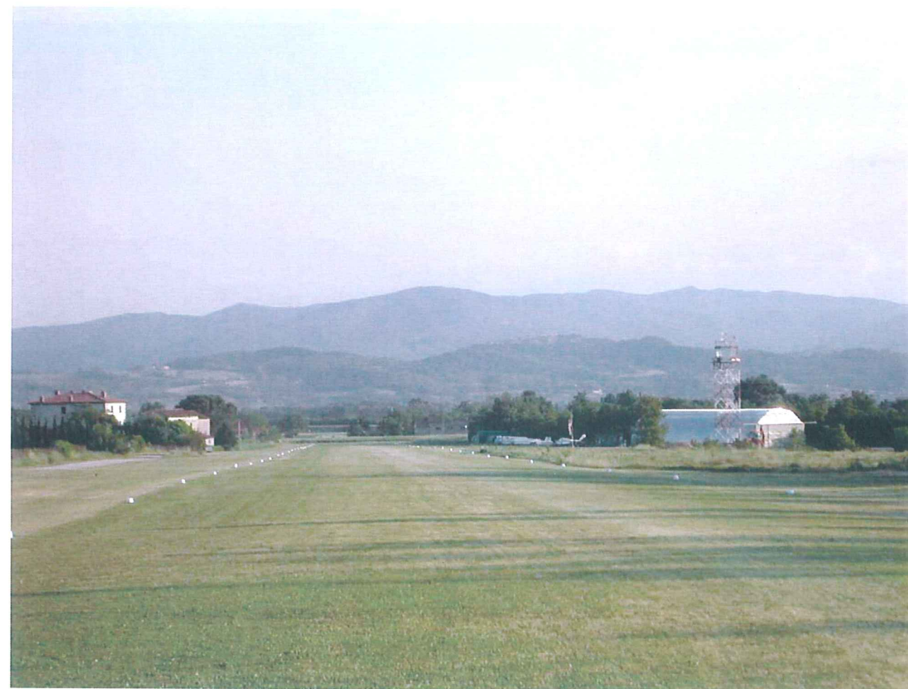
foto hangar esistente
